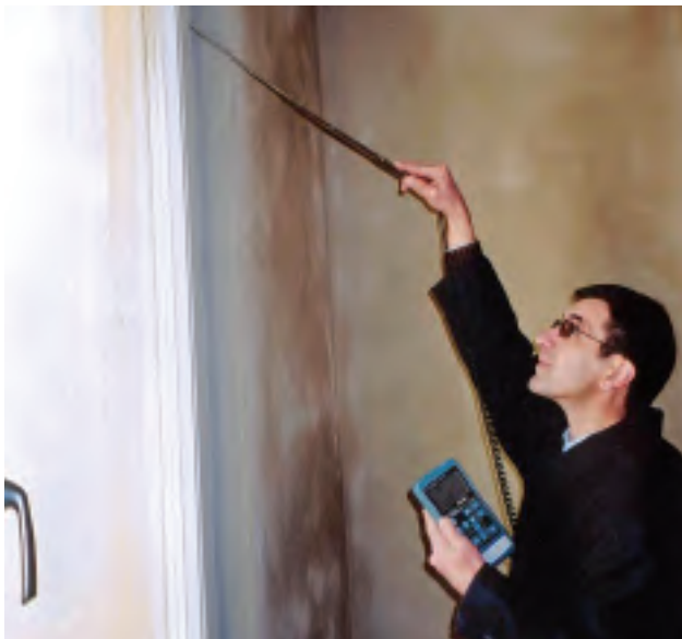
Monitoraggio tenuta serramenti durante il Blower door test.
