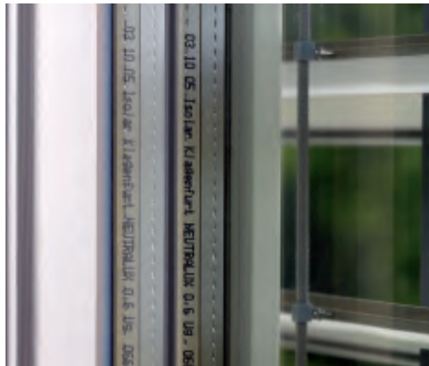
Dettaglio triplo vetro basso emissivo con doppia camera e gas argon.
